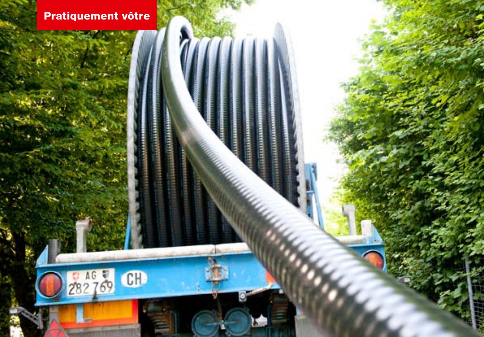
CALPEX livre la bonne longueur de tube sur le chantier directement.
