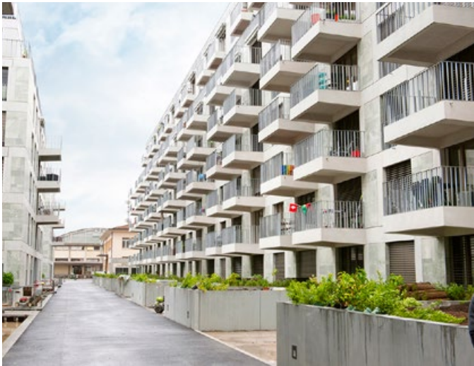
Quartier Val Ouest à Lausanne: le complexe mise sur l'utilisation d'énergie durable.
