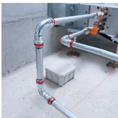
Des anneaux de plastique qui tombent dès que le raccord est sertir. VSH SudoPress est le seul fournisseur à proposer ce type de raccords à sertir.
