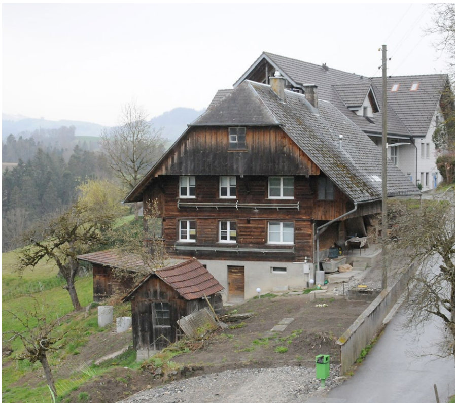
Mit der Sanierung erhielt das Bauernhaus eine zeitgemässe Wärmedämmung und Heizungslösung.
