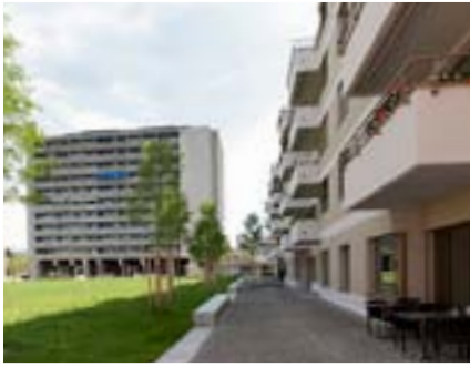
Oase in der Grossestadt: Minergie-Mehrfamilienhaus Sackzelg in Albisrieden.
