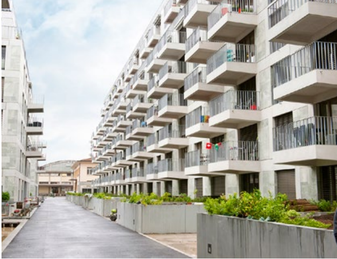
Val Ouest in Lausanne: Die Überbauung setzt auf die Nutzung von nachhaltiger Energie.
