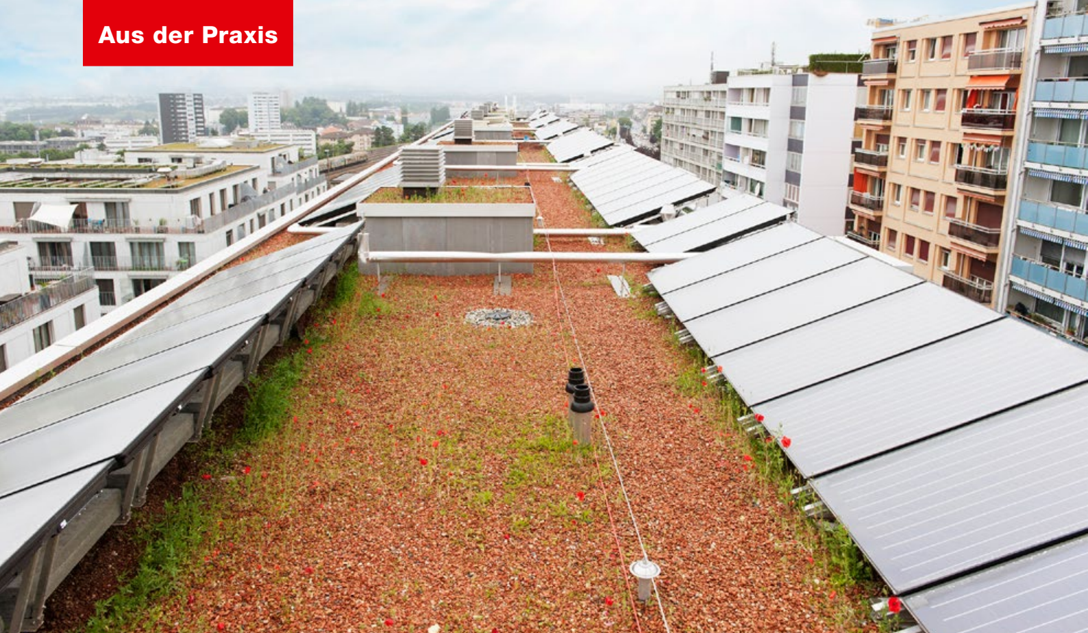
Mit 335 m 2 Gesamtfläche produziert die thermische Solaranlage in Lausanne Warmwasser für insgesamt 367 Wohneinheiten.
