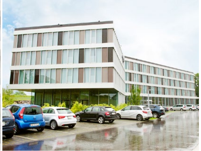
Hotel Modern Times in Vevey: Die thermische Solaranlage deckt rund 45 % des Warmwasserbedarfs ab.
